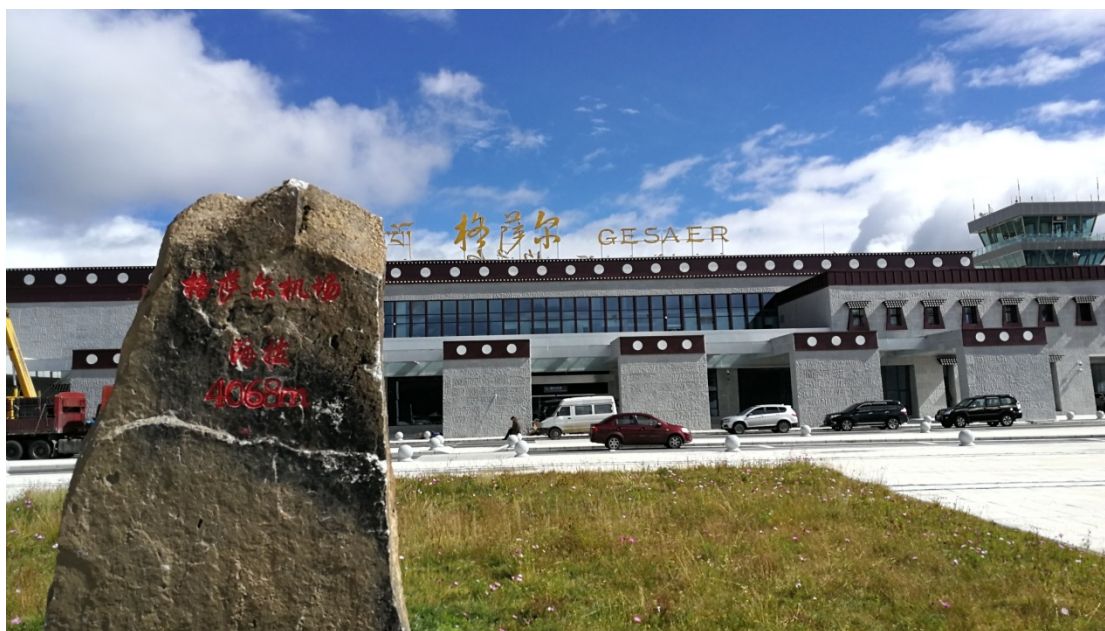
图1 甘孜格萨尔机场航站楼（机场标高 4068m）
