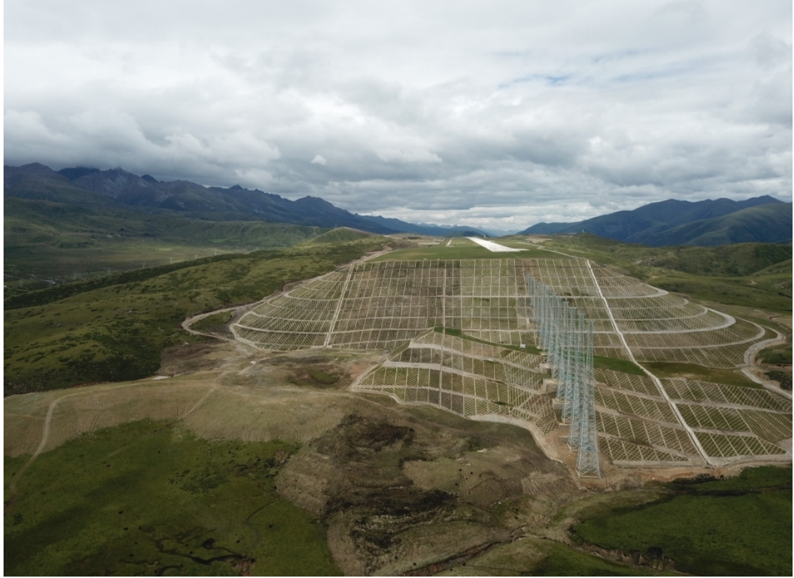
图3 甘孜机场东南端高边坡和铁塔（东南往西北视图）
