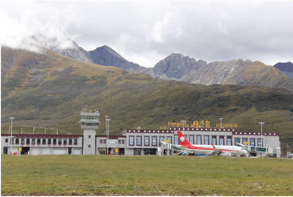
图 11 甘孜机场航站楼和停机坪
